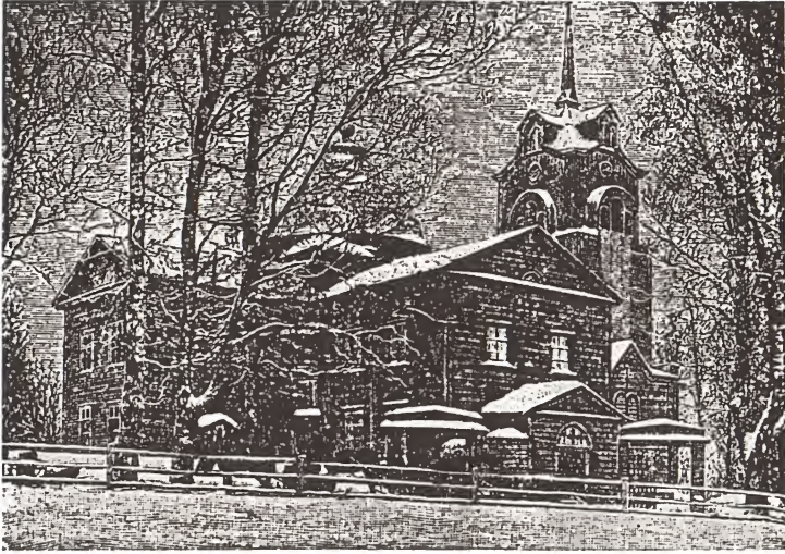
Kelton kirkko. Rakennettu v. 1768. 800 istumapaikkaa.
